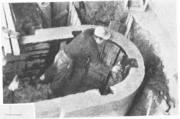
第16図 基礎工事アスファルト防水作業
